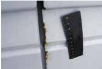
3. Dellen, Beulen oder Kratzer, bei denen die Lackschicht bis zum Trägermaterial beschädigt ist und Roststellen zu sehen sind. Roststellen sind in jedem Fall inakzeptabel.
